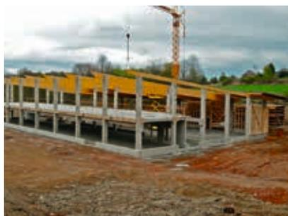
Ossature principale : poutres en lamellé collé sur piliers en béton armé
