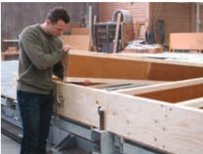
Préfabrication des murs et de la toiture avec STEICOjoist et STEICOwall. STEICO LVL constitue les lisses haute et basse ainsi que les cadres latéraux.
